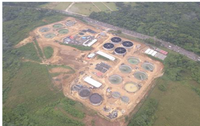
Vista actual de la Estación Depuradora del Rio Ozama
