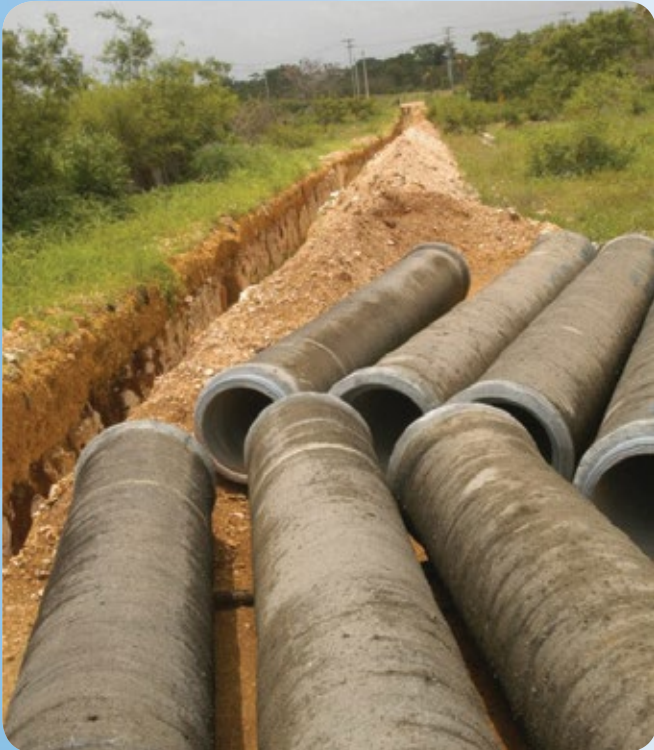
Colocación de tuberías Hipódromo V Centenario
