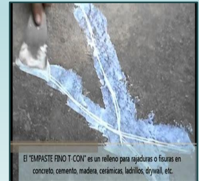
Sellante o reparación de la Fuga por Grieta
